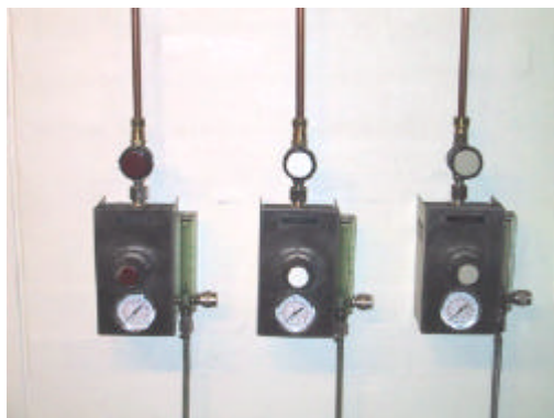
Figur 3.75 Eksempel på udtagsposter ved centralanlæg.
