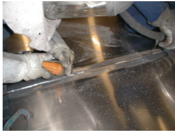
Figur 2.149 "Fræsning" af start/stop hæftninger. Ved reparation bruges vinkelsliber og fræser.
